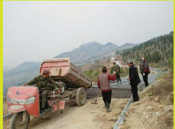
重汽路硬化施工
